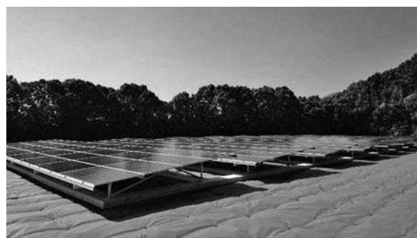
Photo. 1 配水池上部に設置した太陽光発電設備
