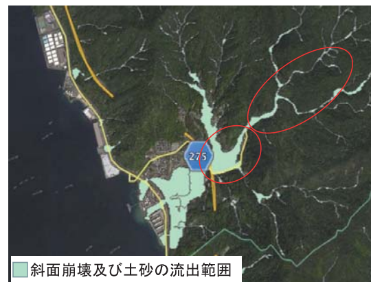
Fig. 5 平成 30 年 7 月 豪雨災害調査団 (地理学グループ) による 広島県の斜面崩壊分布図
