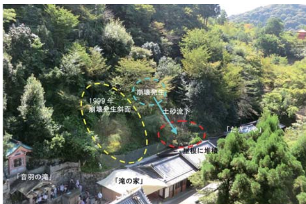
Fig. 1 2013年の8月における音羽の滝横の斜面崩壊の様子（発生から1日後）
