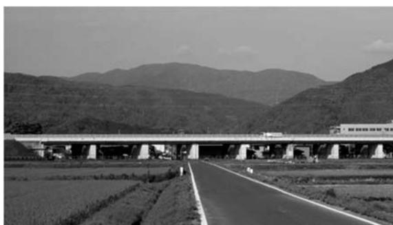
Fig. 7 避溢橋の設置例 (長浜市)
