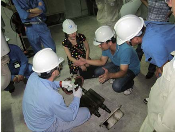
Photo. 4 現場で、ルーツブロワの分解修理状況
