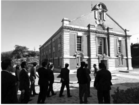
鍋屋上野浄水場 旧第一ポンプ所前
