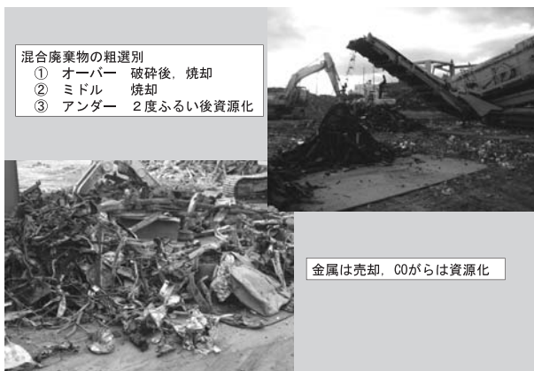
混合廃棄物の選別処理状況
