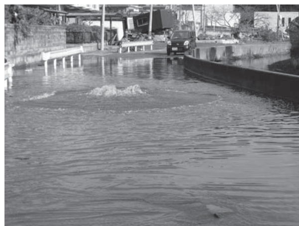
Photo 2 マンホールからの汚水の溢れ出し
