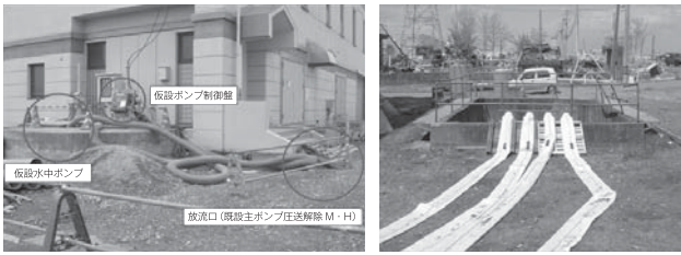
Photo 5 左：中野ポンプ場（汚水）の仮設状況 右：西原排水ポンプ場（雨水）の仮設排管
