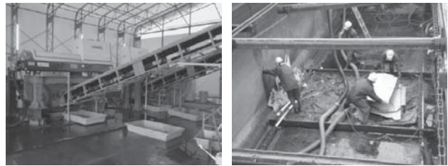
Photo 7 左：仮設脱水機 右：初沈内の瓦礫等撤去作業
