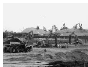
(地盤改良状況写真)
