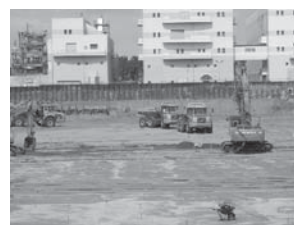
(掘削状況写真)
