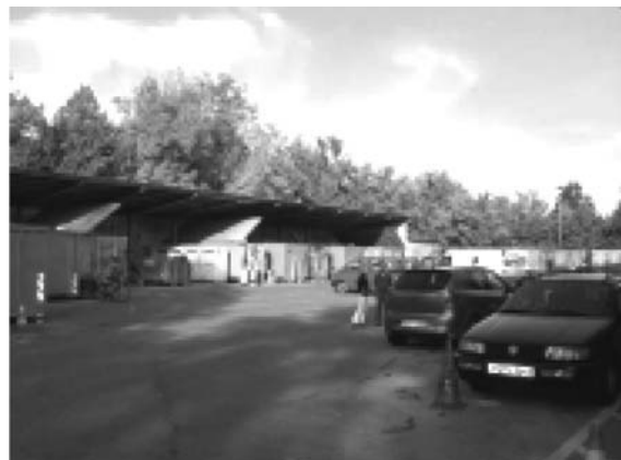
Photo. 1 リサイクルセンター
