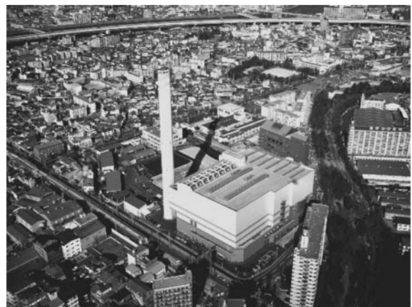
Fig. 1 西淀工場全景
