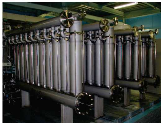
Fig.2 膜処理施設
