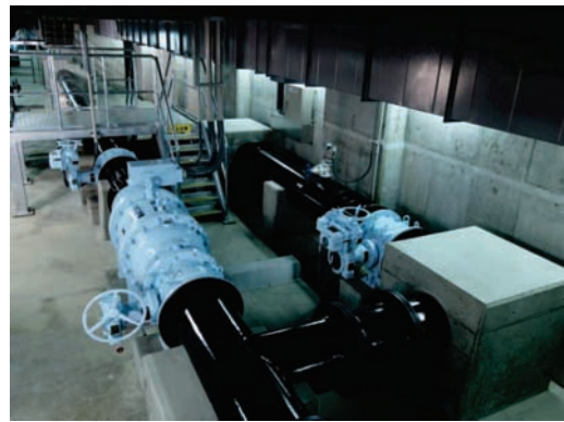
Fig.5 小水力発電設備
