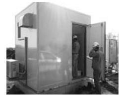
Fig.6 屋外キュービクルでの現場設置
